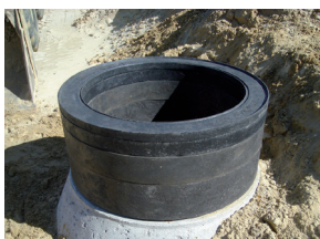
Ø600 topringe på beton kegle.
