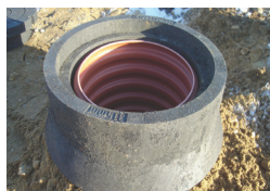
Kegle anvendt på opføringsrør.
