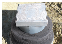
Brøndgods i kegle med indlægsring/asfaltstop.
